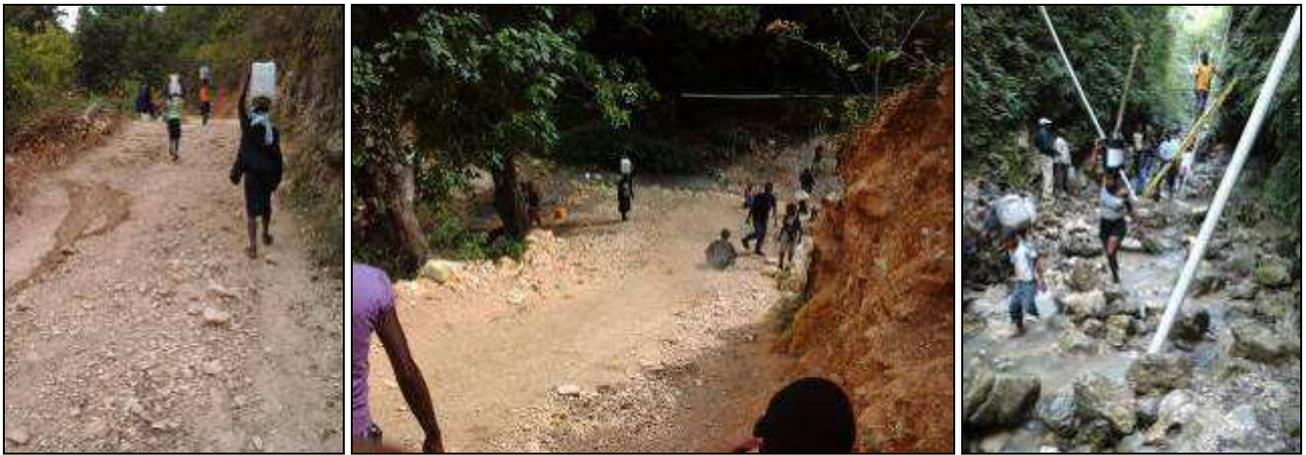
Des réparations sont en cours, supervisées par un technicien de la DINEPA (Direction Nationale de l'Eau Potable et de l'Assainissement), pour corriger la pente des canalisations, et remplacer les canalisations défectueuses.
