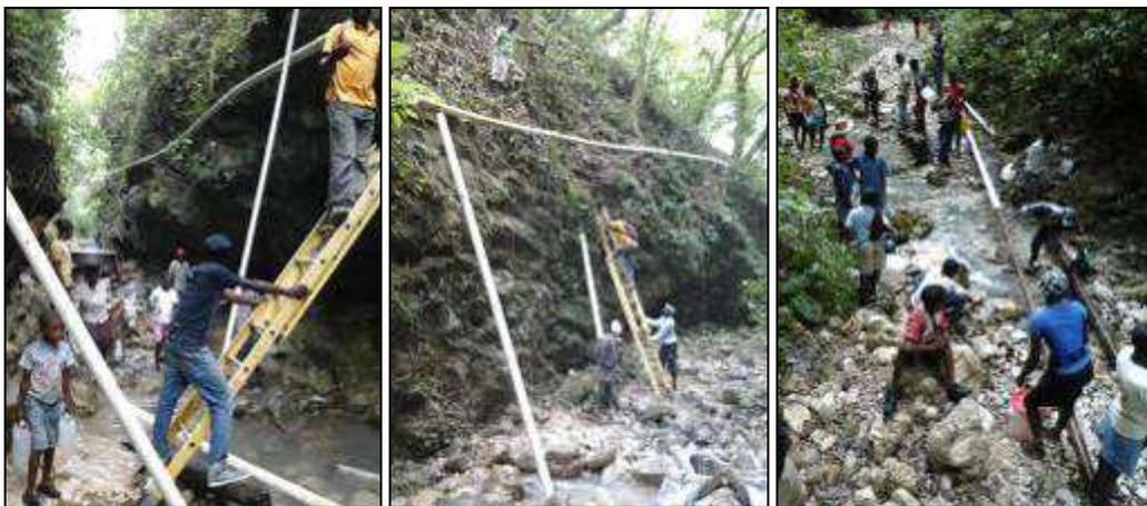
Les canalisations d'origine ont été remplacées au fil des ans et des intempéries par des tuyaux en PVC, qui courent sur le sol, ou sont suspendus le long des parois encaissées de la rivière, attachés par des fils de fer et supportés par des piques en PVC. Le système est fonctionnel la majeure partie de l'année, mais chutes de pierres, intempéries, vents violents, le rendent inopérant à une fréquence plus ou moins régulière, en tout cas plusieurs fois par an pour des périodes de plusieurs jours.
